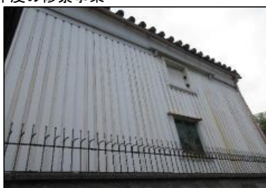
(改修前) 撮影日：令和2年9月12日
