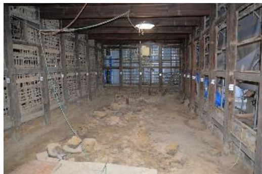
道具蔵1階床及び壁解体 (令和2年10月8日撮影)
