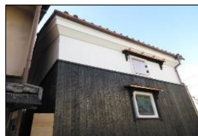
(改修後) 撮影日：令和3年1月21日
