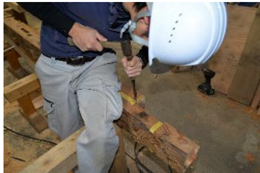
柱根継の加工風景 (令和2年11月27日撮影)
