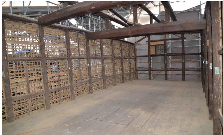
井上関右衛門家住宅(鉄砲鍛冶屋敷)保存修理工事写真
