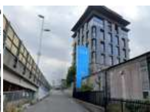
自立広告塔の撤去事例
