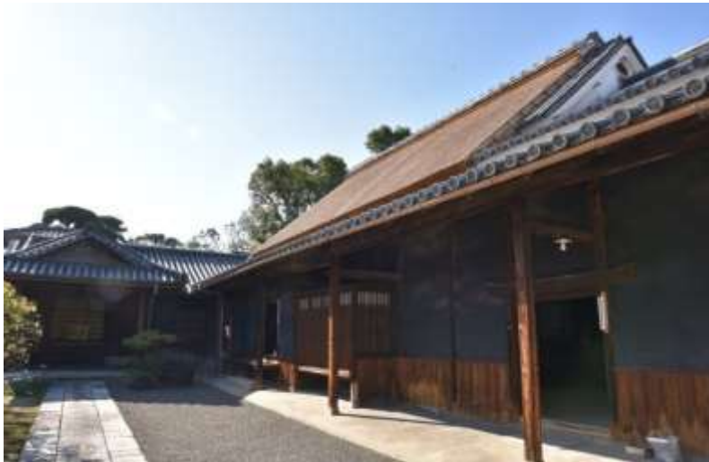
高林家住宅主屋竣工全景
