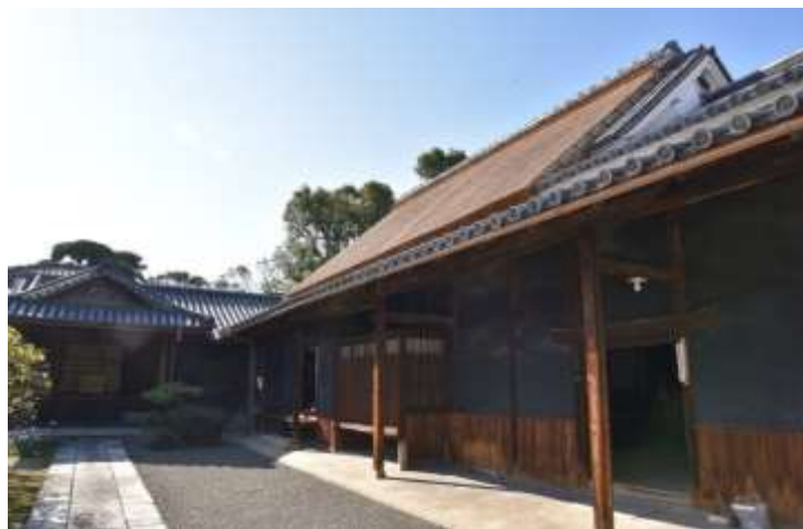
高林家住宅主屋竣工全景
