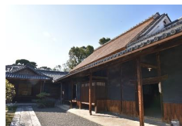
竣工後の高林家住宅
