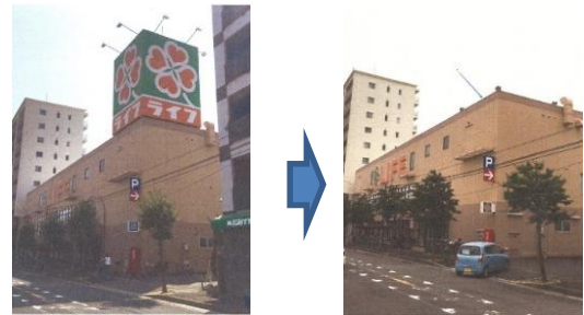
屋上広告物撤去事例
