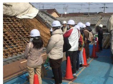
修理中の現場公開の様子 H30.2
