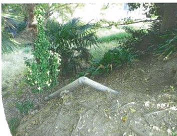
露出した配管
