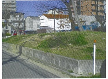
道路際の擁壁と土留めブロック
