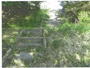
墳丘に設置された階段
