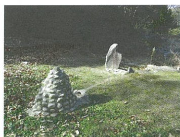
送水管に関する施設
