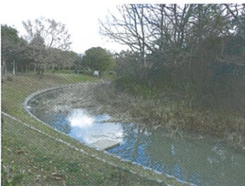
間知石で整備された護岸
