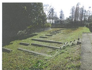
周濠に設置された飛石状コンクリートブロックと階段
