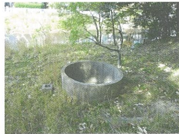
前方部上のコンクリート構造物
