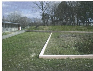
範囲を擁壁で示した前方部
