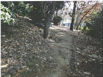
木製の縁石で整備された通路
