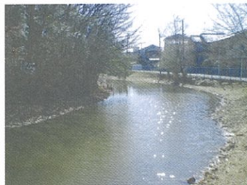
滞水により生じた浸食
