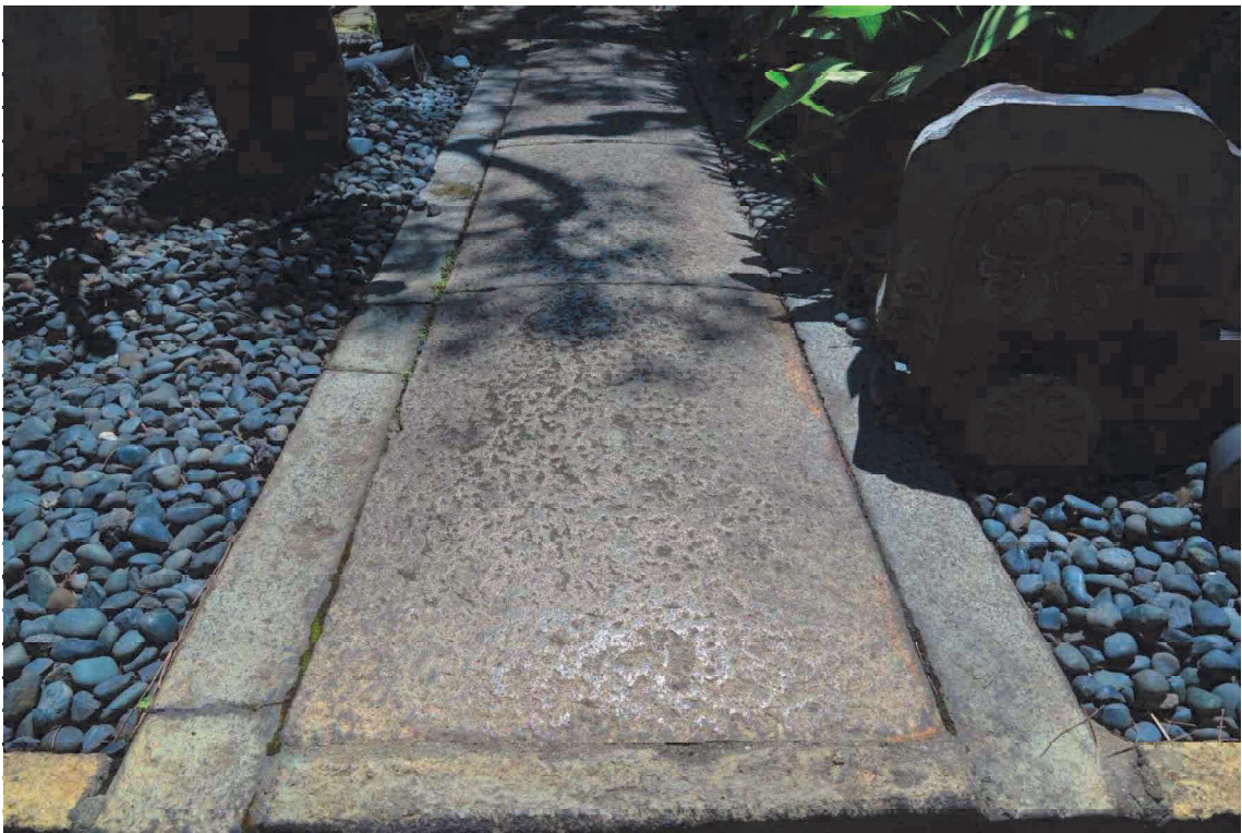
雨水排水を考慮し水勾配加工した御影石の敷石
