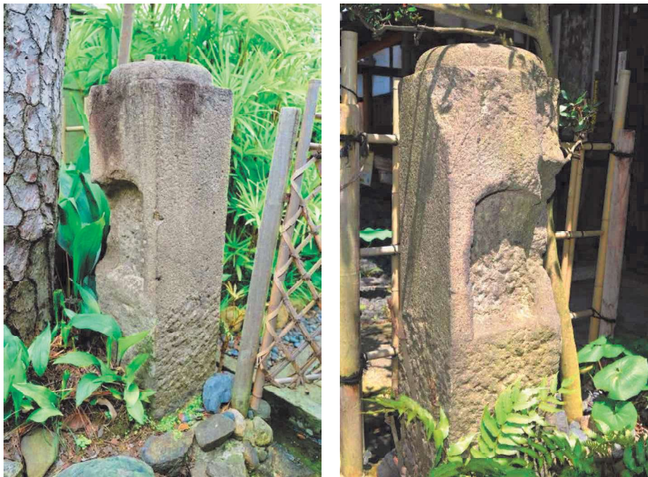
石橋石柱「七反田橋」裏面
