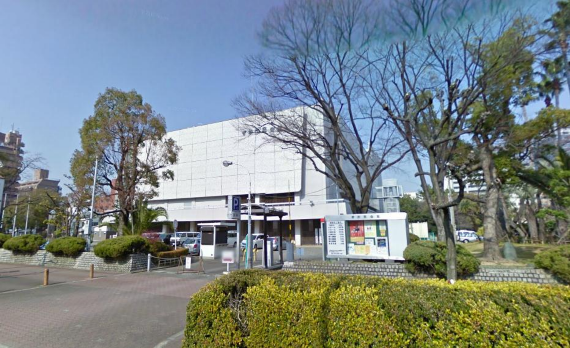
現施設の外觀(国道310号側から)
