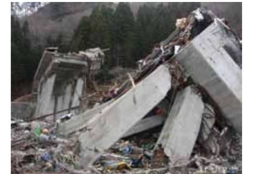
Estación de Shimanokoshi derrumbada Foto proporcionada pelo Instituto de Seguridad contra Incendio y Preparación para Desastres
