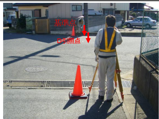
基準点埋設後の点検
