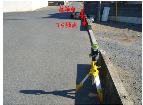
A引照点での基準器による視準(A引照点～B引照点～基準点)
