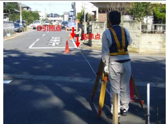
基準点埋設後の点検
