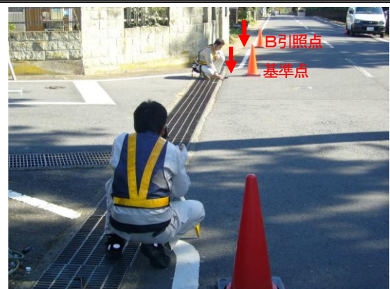
基準点埋設後の点検
