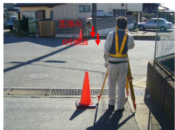
基準点埋設後の点検
