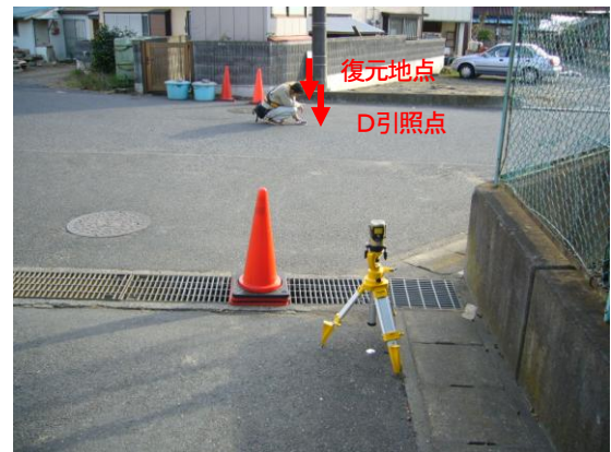
C引照点での基準器による視準(C引照点～D引照点～復元地点)
