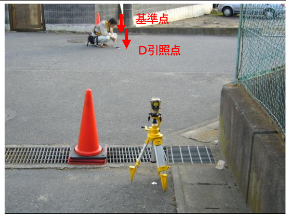
基準点埋設後の点検
