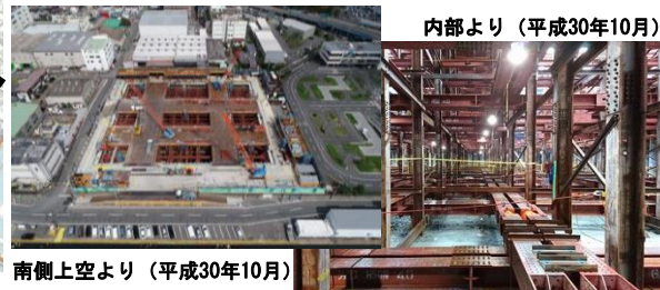
【古川第2ポンプ場】
