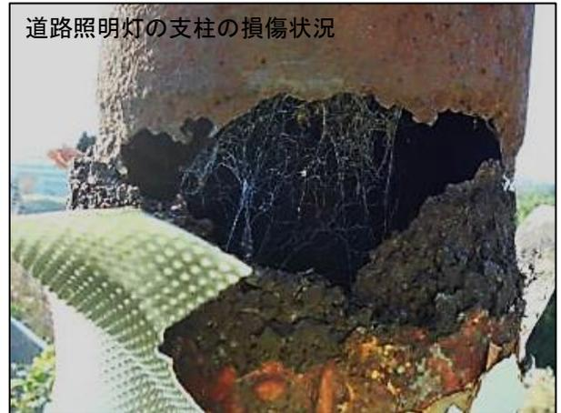
道路照明灯の支柱の損傷状況
