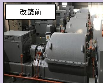
泉北水再生センター 送風機設備
