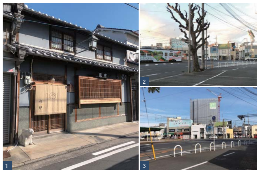
1. 堺の町家のほとんどは戦前の建物ですが、戦後でも昭和25年の建築基準法制定以前に伝統工法で建てられたものは含まれます。この町家は戦後、焼け跡から逸早く再建された、典型的なこの時期の町家です。/ 2. 2018年10月1日撮影 南からマンション予定地方向を望む / 3. 2019年12月24日撮影 建設中のマンション
