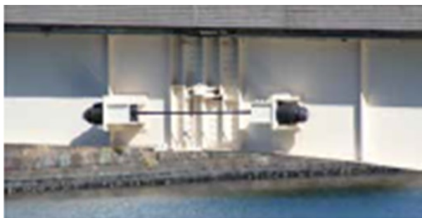
図2 PCケーブル構造（外側の場合）
