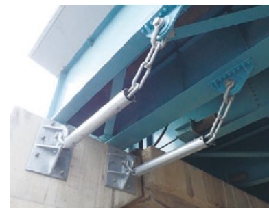
図3 チェーン構造
