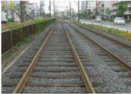
図表 更新した軌道 資料：堺市
