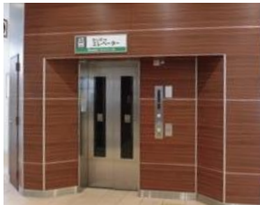
図表 駅舎のエレベーター設置状況 南海高野線三国ヶ丘駅
