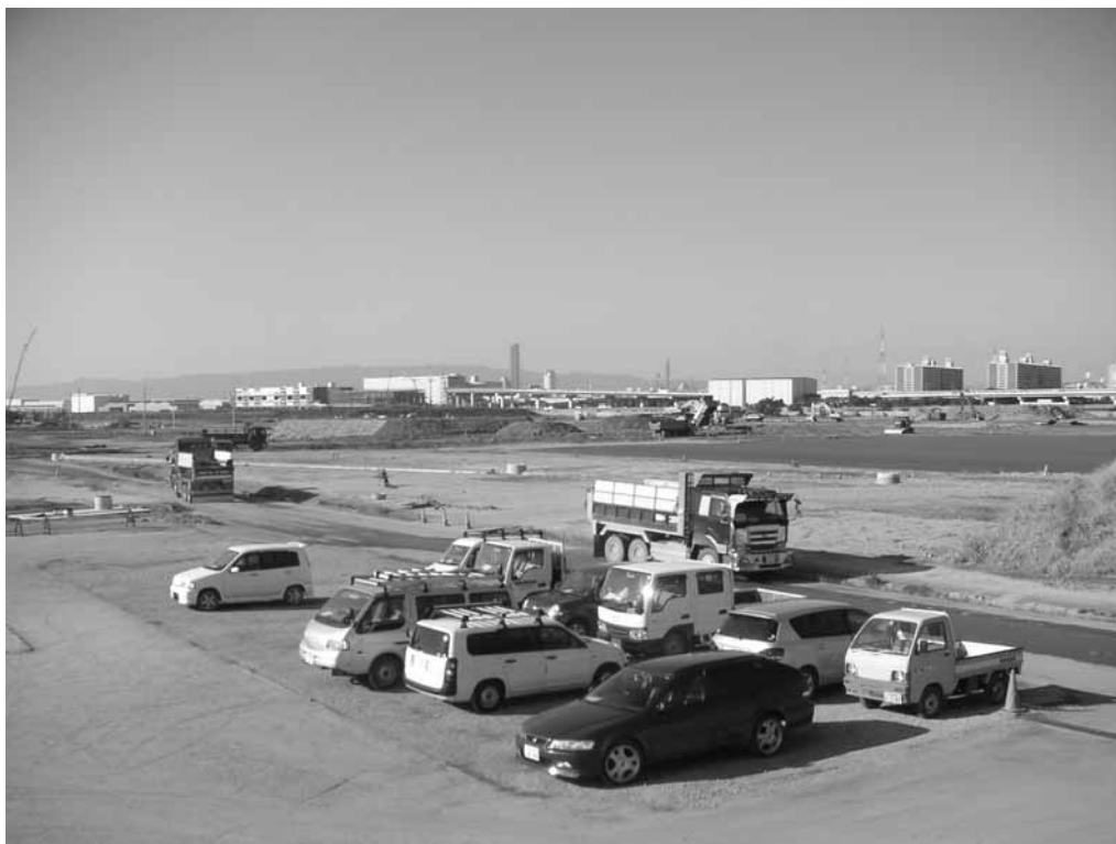
(工事現場写真 撮影平成20年11月)
