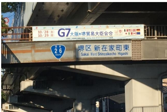
堺市内の歩道橋
