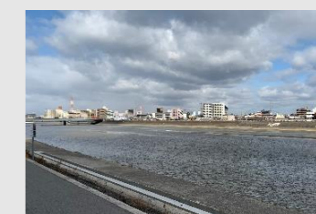
⑱大和川の広がりある景観
