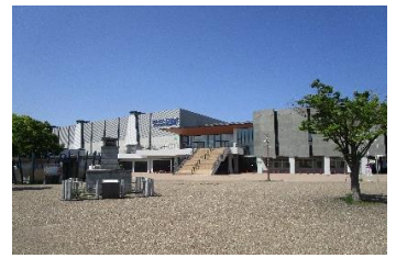
大浜体育館・大浜武道館
