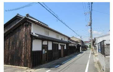
現存する伝統的な町家
