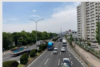
⑤大阪中央環状線
