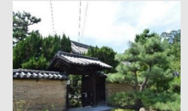
⑧ 寺町の一角を形成し、周囲を土堀で囲まれた南宗寺
