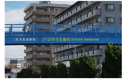
ひのうえ眼科 なかもず院 長曽根東歩道橋
