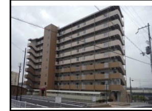
1-A1-3 上野芝住宅 屋上防水改修工事
