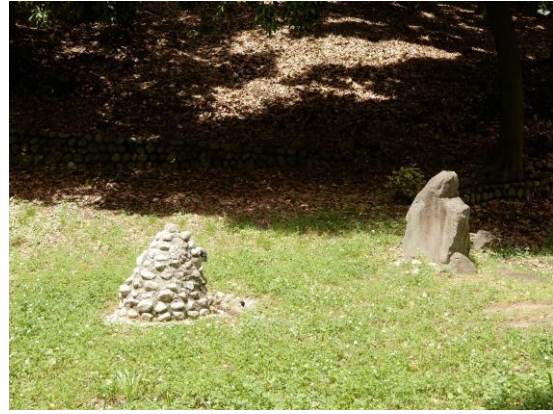
送水管に関連する施設
