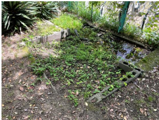
コンクリート構造物
