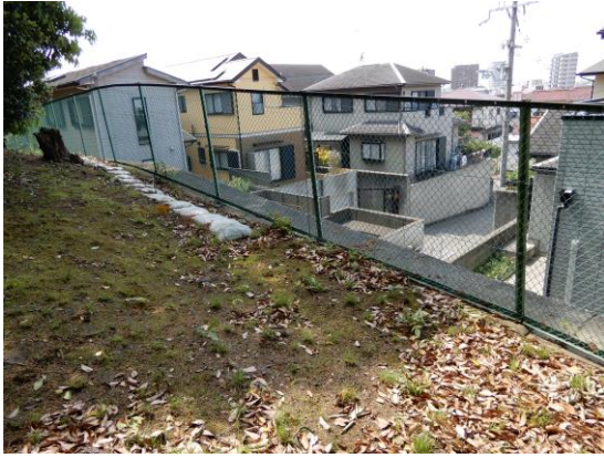
改修した古墳北側のネットフェンス
