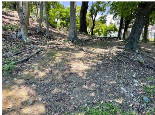
露出した樹根
