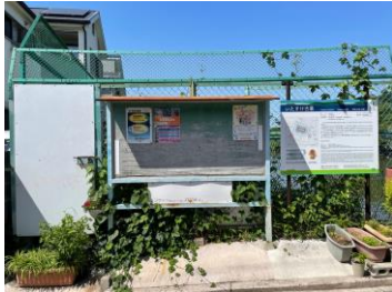
安全管理柵・門扉・説明板
