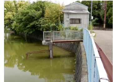
2箇所を設置された樋 (写真は東側)
