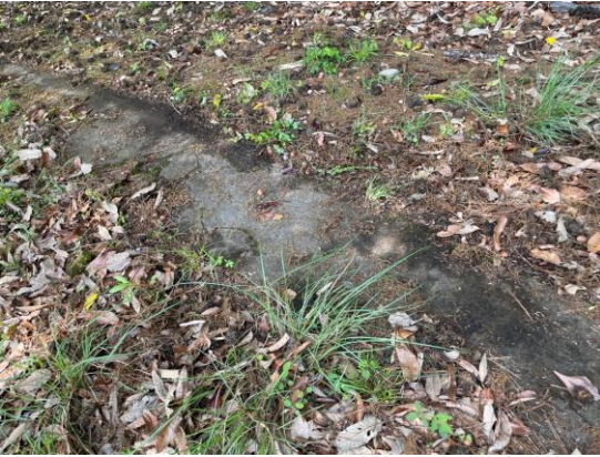
コンクリート構造物
