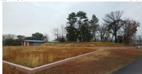
範囲を擁壁で示した前方部
