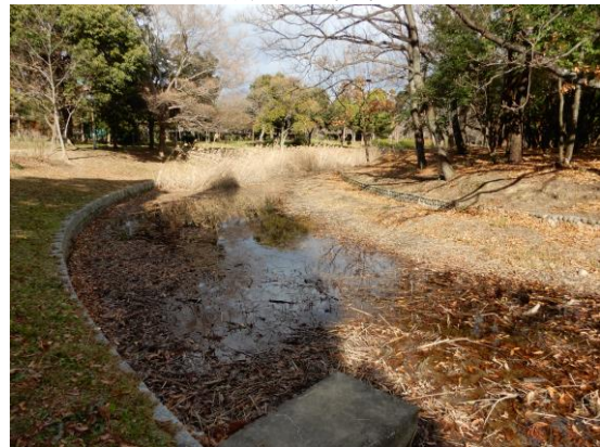
間知石で整備された護岸
