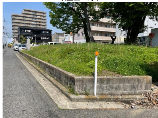
道路際の擁壁と土留めブロック
