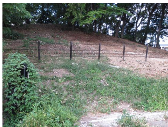
平成 24 年調査前 近景（南から）
