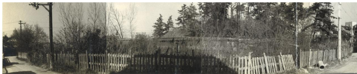
昭和 42 年(1967) 遠景 (南東から)
