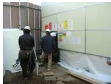
建築物解体現場への立入
