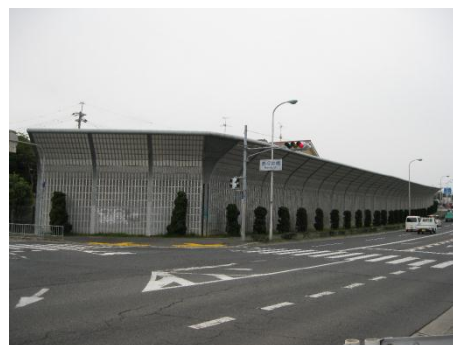
南区赤坂台付近の防音壁
