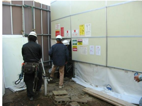
建築物解体現場への立入
