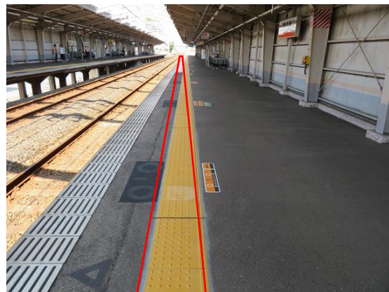
内方線付点状ブロック整備 事後写真
