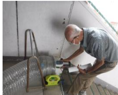
負圧除じん機吹出口の漏えい確認
