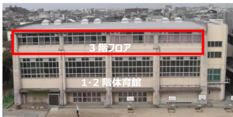
当該体育館の外観
