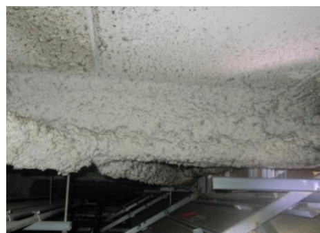
3階天井裏の状況
