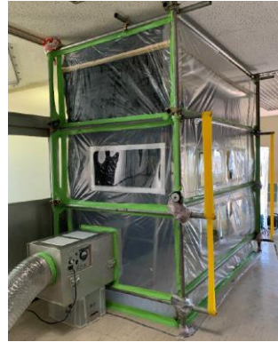
実験工区（負圧除じん機側）
