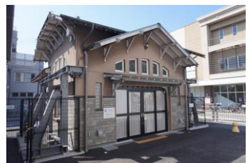
諏訪ノ森駅前の旧駅舎
