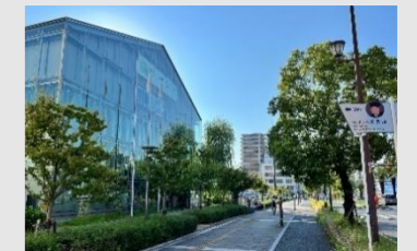
⑮ モダンなデザインでランドマークとなっているさかい利晶の杜
