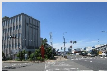
⑦美原都市拠点周辺
