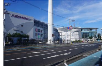
北花田駅前の商業施設
