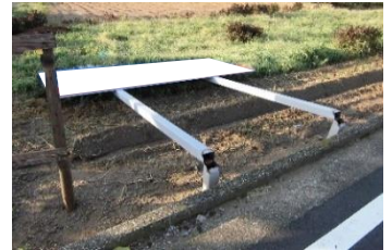
屋外広告物の倒壊
