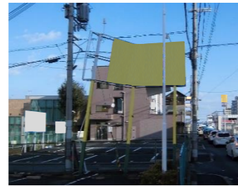
屋外広告物の板面の破壊
