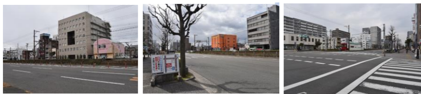
大道筋沿いに建ち並ぶさまざまな規模の建築物 大道筋沿いのめだつ中規模建築物 SMI プロジェクトによる整備が想定される交差点
