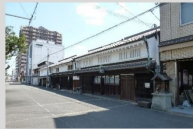
⑪ 古くからの町家が残る大道筋沿いのまちなみ
