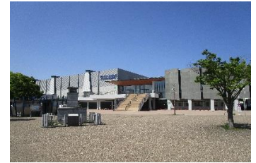
大浜体育館・大浜武道館
