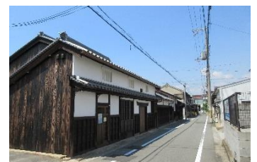
現存する伝統的な町家
