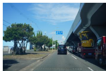
泉大津美原線（松原泉大津線）・ 阪和自動車道
