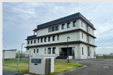
7 堺泉北港堺2区基幹的広域防災拠点
