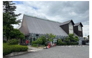
大阪木材工業団地協同組合会館
