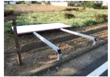
屋外広告物の倒壊
