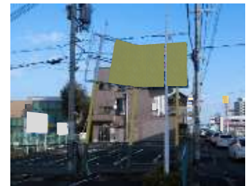
屋外広告物の板面の破壊
