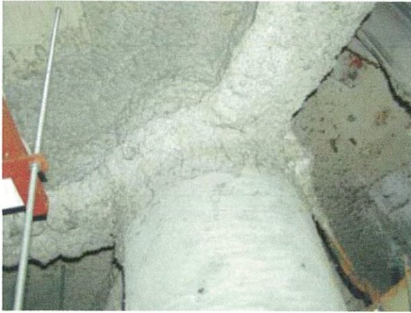
鉄骨耐火被覆
