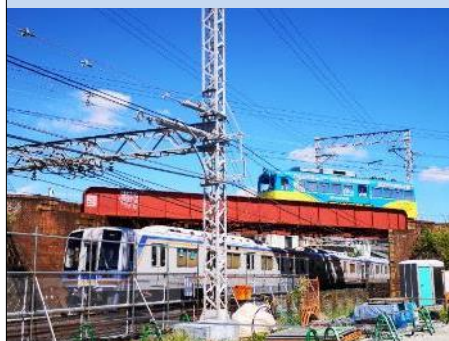
阪堺線立体交差状況
