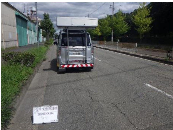
路面性状調査車による舗装の劣化状況の調査
