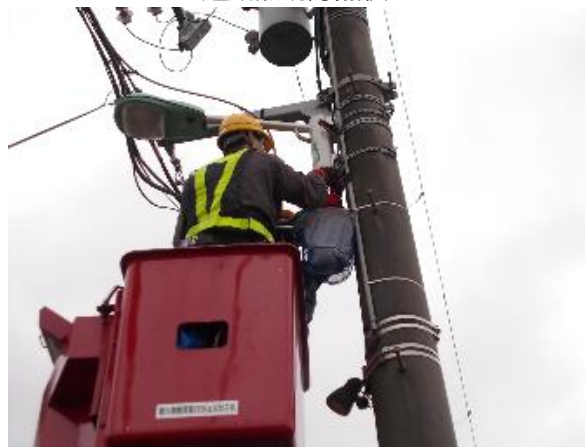
道路照明灯点検
