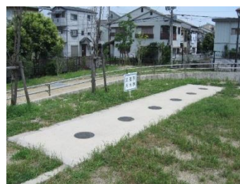
公園の防災施設
