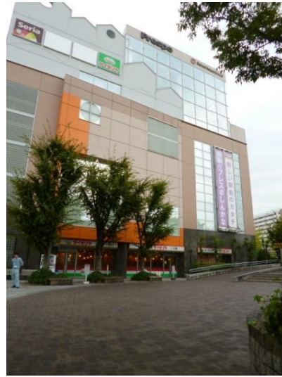
隣接する商業施設
