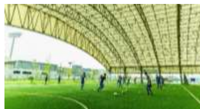
屋根付きフットサルフィールド(3面) サッカーのハーフトート利用や企業等の運動会等の多目的スペースとしても利用されています。
