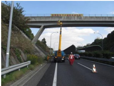
橋りょう点検
