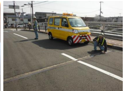
日常点検（パトロール）
