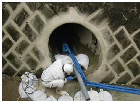
護岸補修状況
