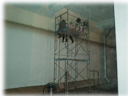
配水池内の点検・調査
