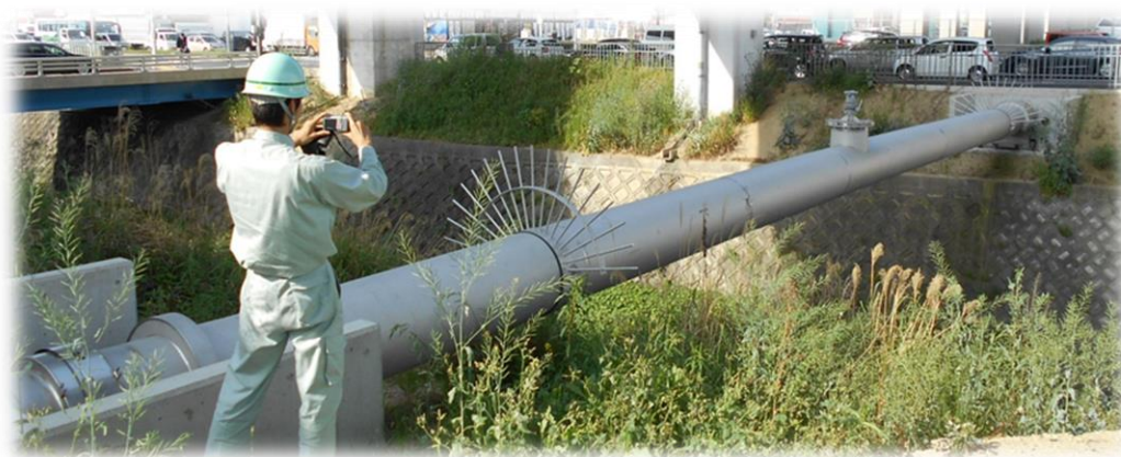
水管橋の点検・調査
