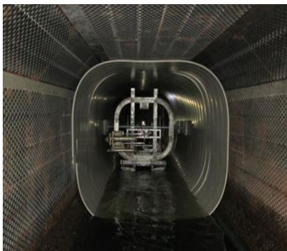
下水道管耐震化更生工事
