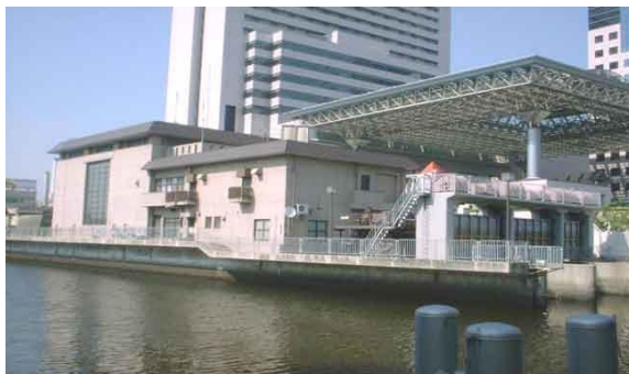
■内川排水機場（堺区戎島町）
