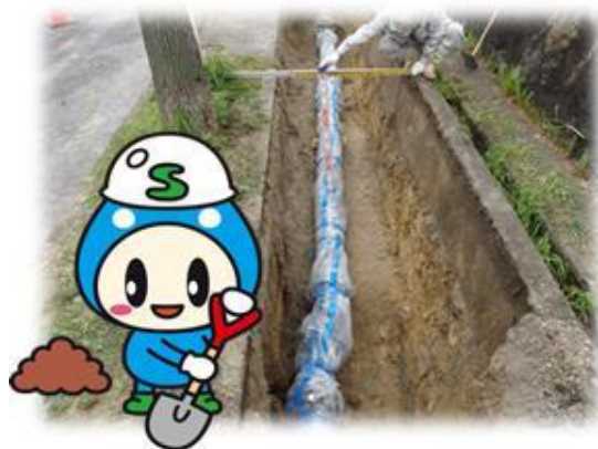
水道管の更新
