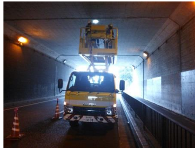
トンネル点検
