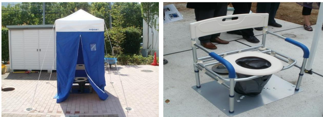
図 マンホールトイレの設置状況
