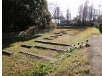
周濠に設置された飛石状コンクリートブロックと階段
