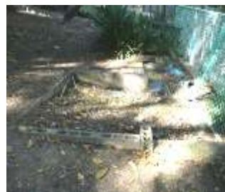
コンクリート構造物
