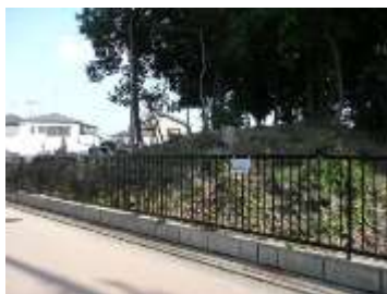
フェンス・擁壁
