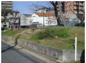
道路際の擁壁と土留めブロック
