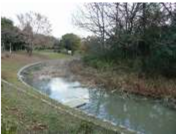
間知石で整備された護岸
