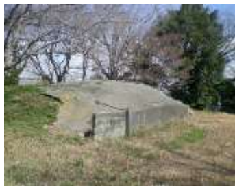
石棺保護モルタルと土留めブロック
