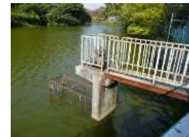
2箇所に設置された樋(写真は東側)
