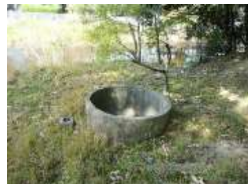
前方部上のコンクリート構造物
