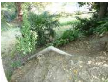
露出した配管
