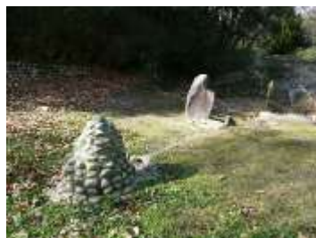
送水管に関連する施設
