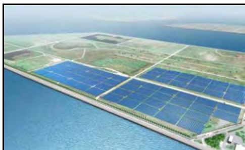
図 堺第 7-3 区太陽光発電施設
