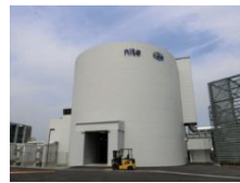
■ 多目的大型実験棟
