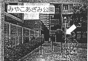
みやこあざみ公園 公園から度々ボールが飛び出し、隣接マンションの立体駐車場に、出口付近に防護フェンスを設置
