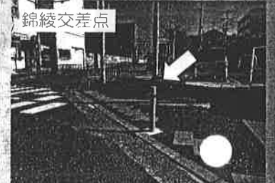
車の飛び込みによる事故の防止のためにボールを設置。
