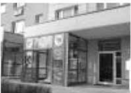
団地1階部分を店舗に改修
