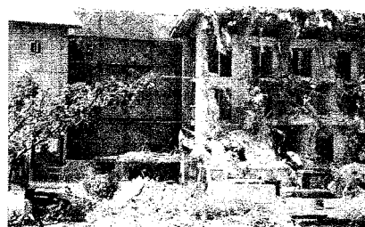
図10：築後6~7年の建物が借しげもなく解体される（神戸市東灘区）
