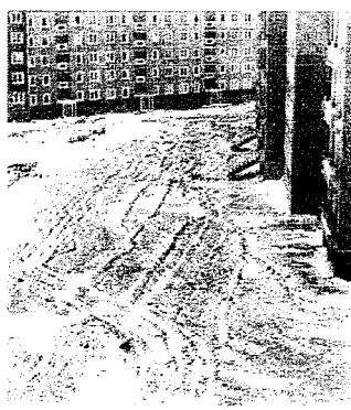
図 1：再生前のヘラースドルフ団地
