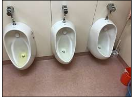
保育園トイレ状況
