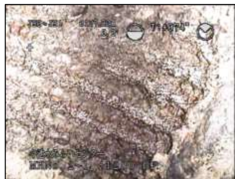
管内面の劣化状況
