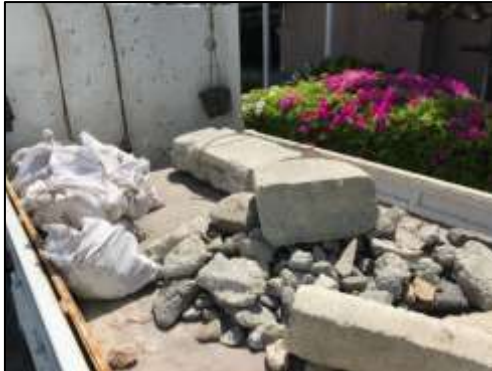
推進時に回収されたコンクリート殻
