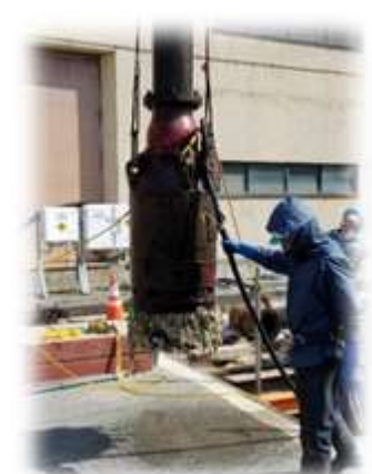
雨水仮設ポンプの清掃状況
