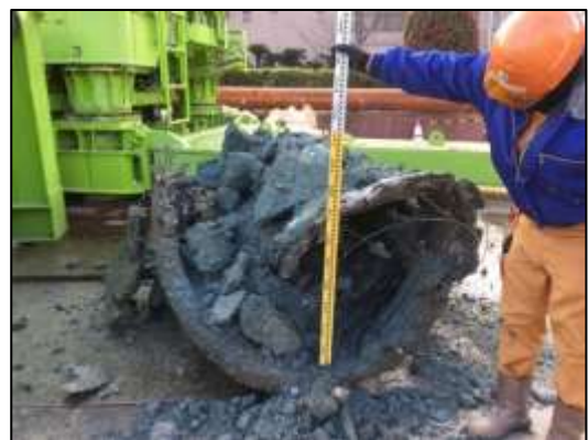
立坑築造時における下水道管の撤去状況写真
