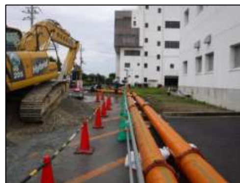
φ350mm 鋼管設置状況
