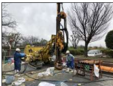
ボーリング調査状況
