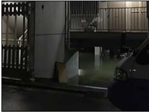
地下駐車場浸水状況
