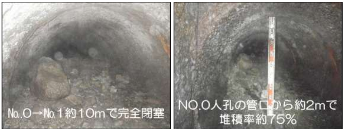
今池水みらいセンター内に布設している堺市公共下水道管 (金岡東線：口径 1,200 mm) の破損による下水道管の管路内閉塞状況
