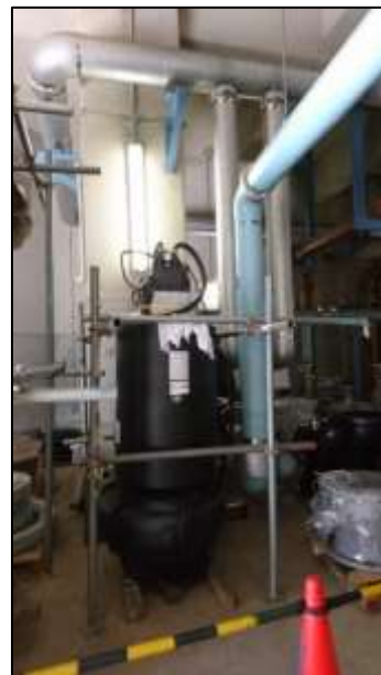
汚水ポンプ \phi 400\text{ mm}
