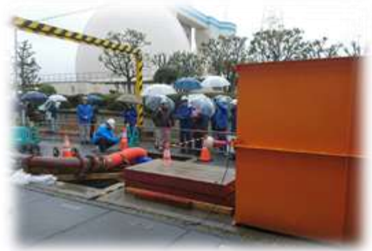
災害査定（実地査定状況）
