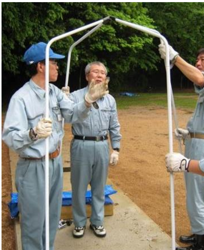
8-4. 屋根部材に柱部材を挿入する
