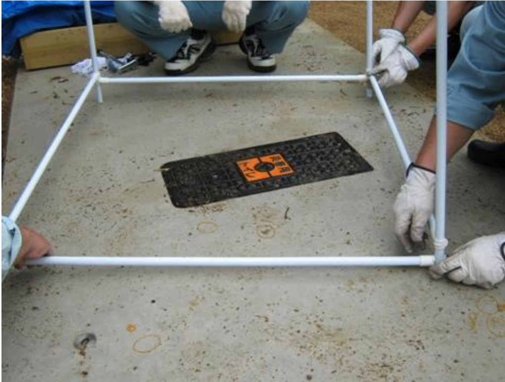
8-6. 便座前後の連結パイプを下側にし、テント取り付けフックの内側に置く
