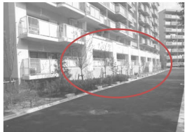
■公営住宅の耐震改修
