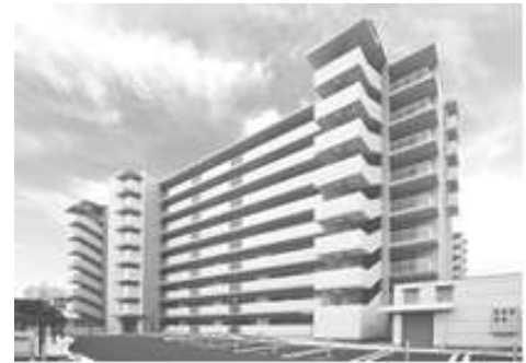
■市営住宅(建替住宅)
