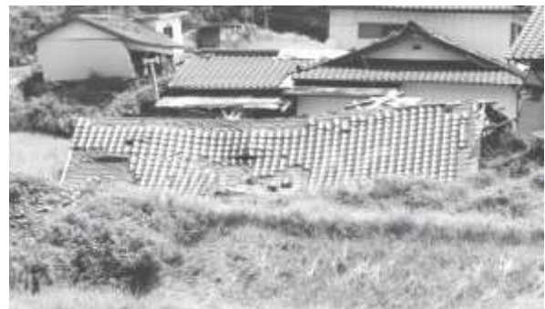
■熊本地震・被災住宅
