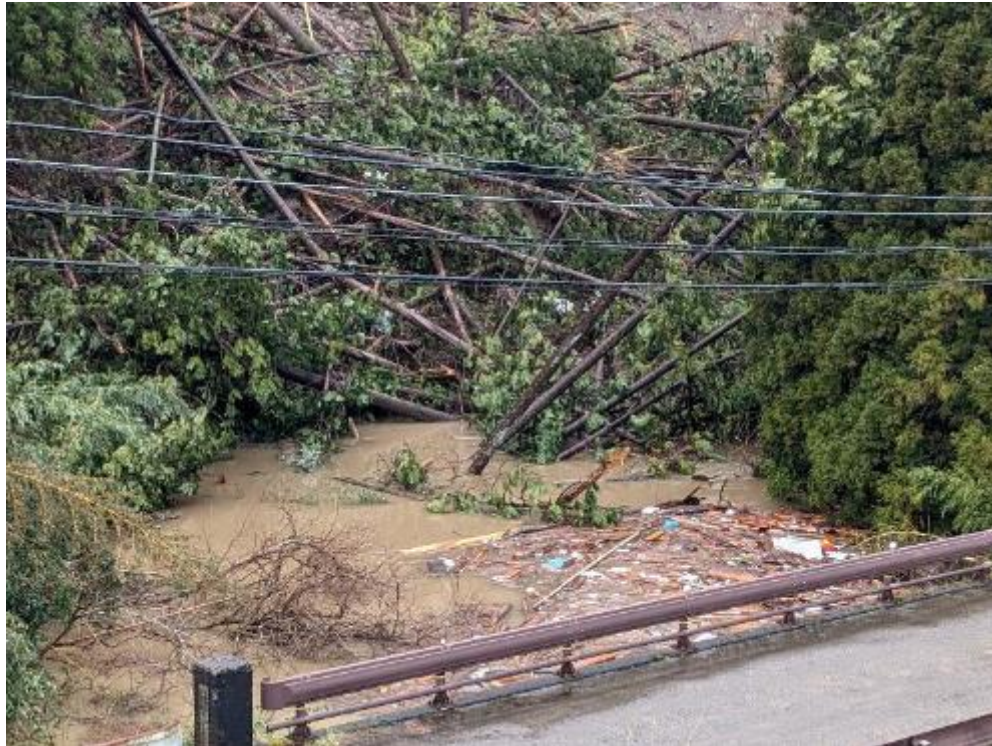
河川閉塞箇所確認
