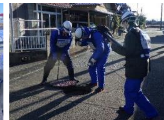
下水道管路調査
