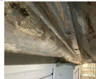
外部露出部アスベスト除去後写真
