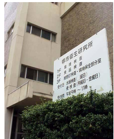
衛生研究所外観(昭和 40 年建築) (衛研だより創刊号掲載)
