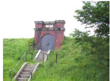
旧天王貯水池正面入口（中三国ヶ丘町） （衛研だより第 9 号掲載）
