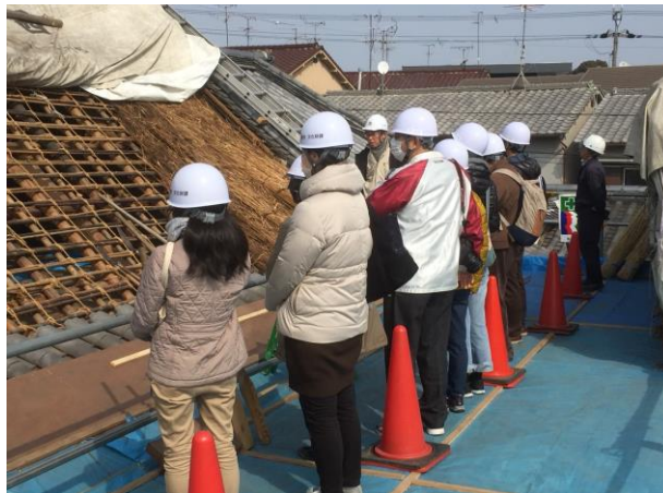
修理中の現場公開の様子(平成30年2月24日)
