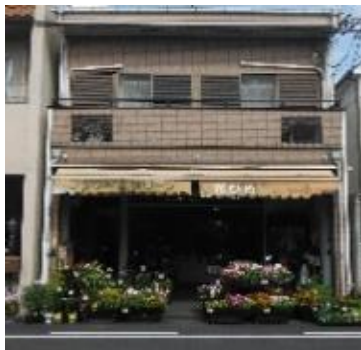
施工内容：（外壁）漆喰風塗装、（手摺壁）虫籠窓風修景、その他：木製看板・軒灯設置 等
