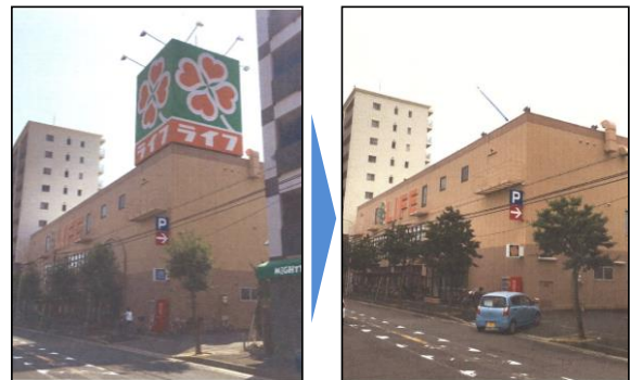
【屋外広告物適正化の事例(屋上広告物撤去)】
