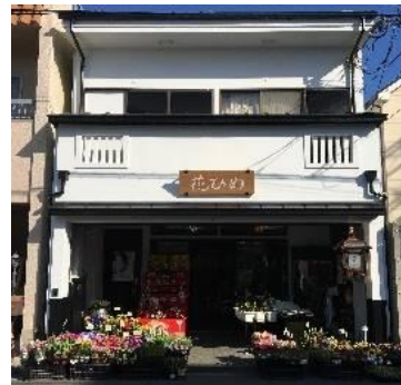
施工内容：（外壁）漆喰風塗装、（手摺壁）虫籠窓風修景、その他：木製看板・軒灯設置 等
