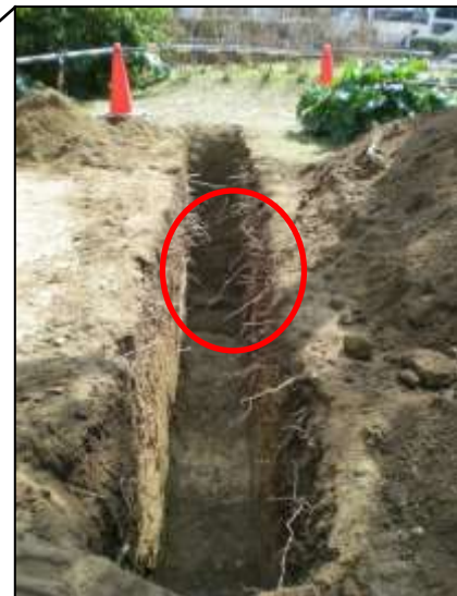
■試掘状況写真
